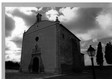
Capella de la Mare de Déu de la Misericòrdia
